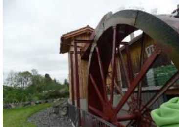
Das Mühlrad liefert Strom
